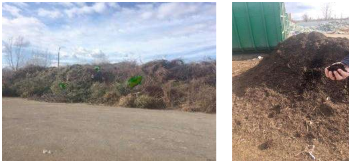
Figura 18: Stația de compostare Aninoasa
