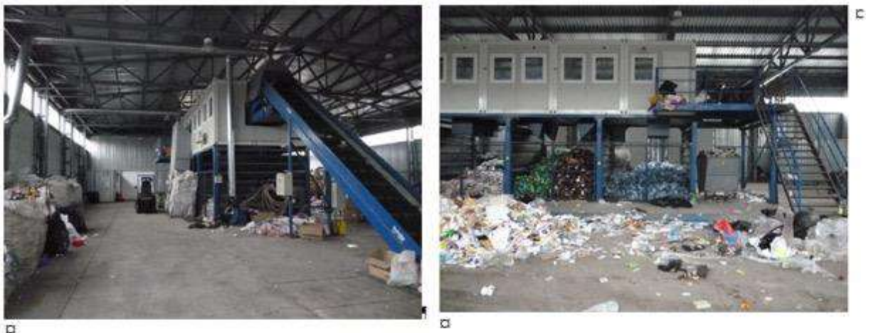
Figura 4-5: Stația de sortare Galați
