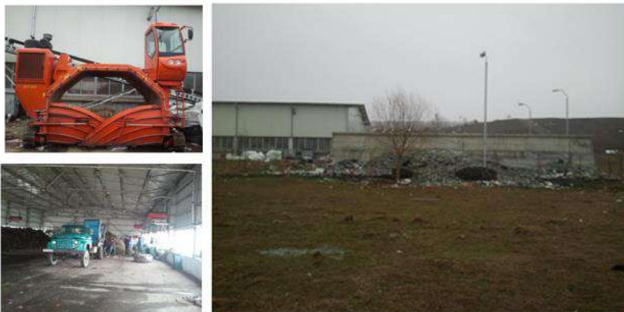
Figura 4-9: Poze stația de compostare Tg. Bujor
