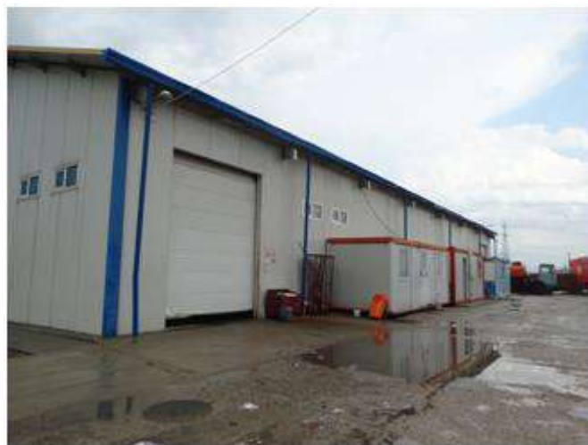
Figura 4-6: Imagine stației de sortare Tecuci
