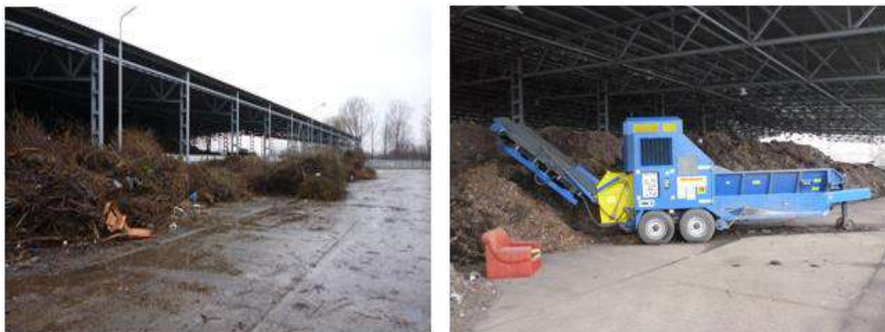
Figura 4-8: Stația de compostare Galați
