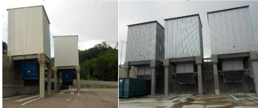
Figura 7-6 Exemplu de transfer prin intermediul unor tobogane în containere deschise
