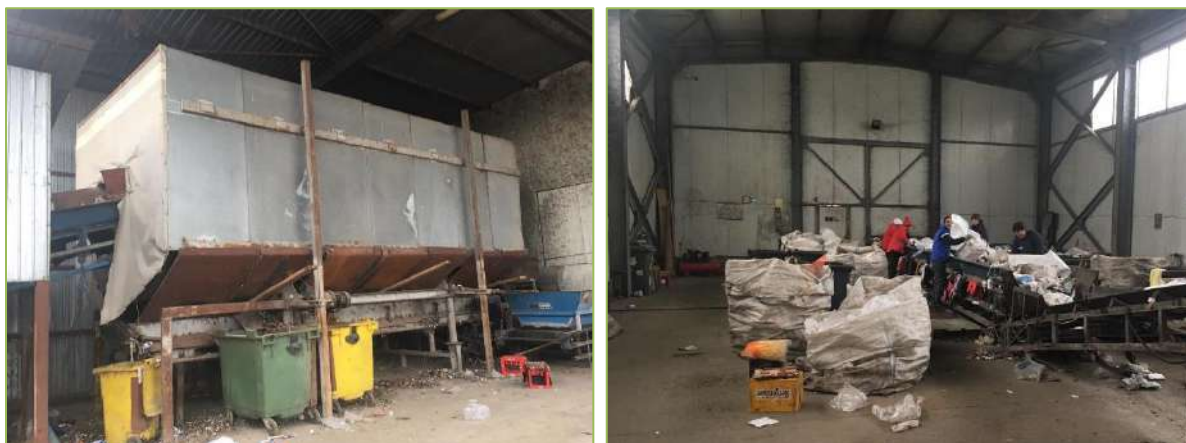
Figura 4-7: Stația de sortare S.C. ADI ECOO 2009 Țândărei
