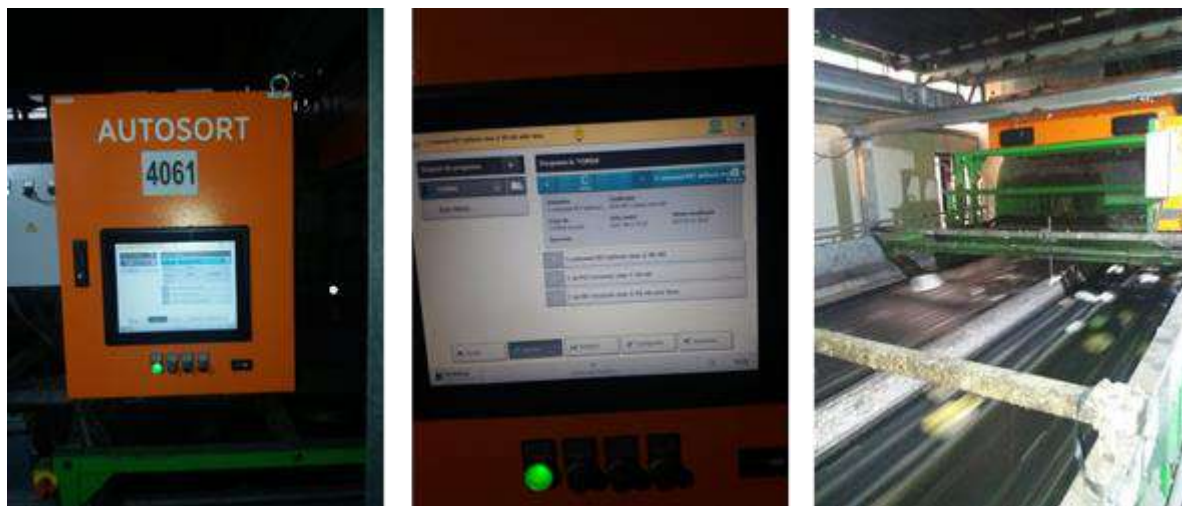
Figura 4-10: Stație de sortare S.C. ROM WASTE SOLUTIONS S.A.
