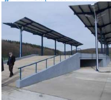
Figura 7-9 Stații deschise de transfer
