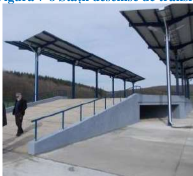
Figura 7-8 Stații deschise de transfer
