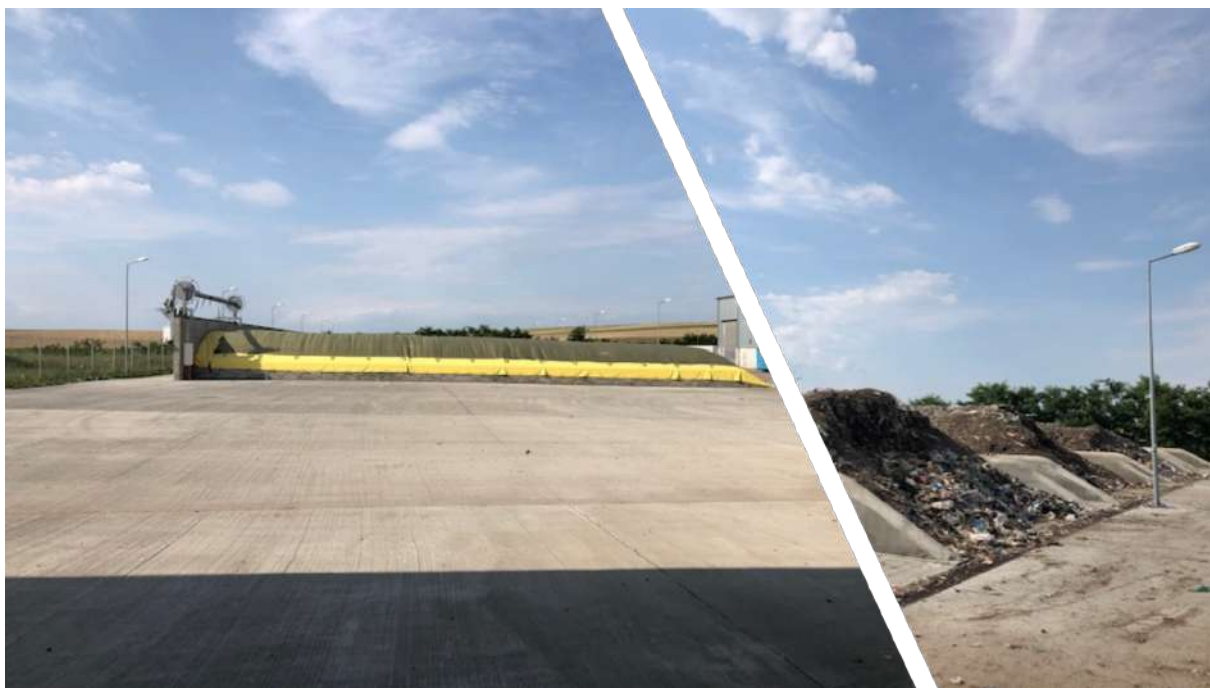
Figura 4-8. Stația de tratare mecano – biologică Mihai Bravu
